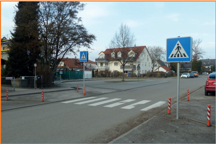
Fußgängerüberweg in der Wolfsgartenstraße
