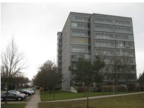
Sanierung Wohngebäude und Wohnumfeldgestaltung Herschelstraße (GWG)
