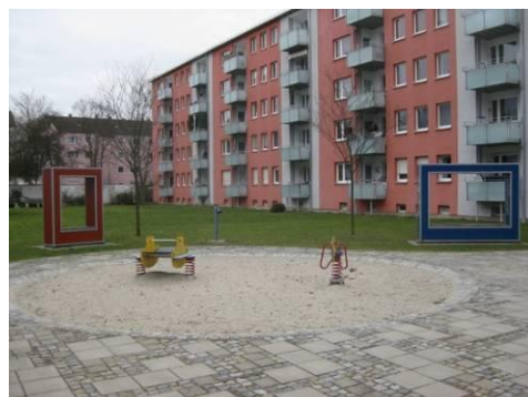
Sanierung Wohngebäude und Wohnumfeldgestaltung Rossinistraße (Südhausbau KG)
