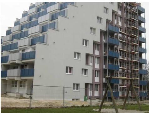
Sanierung Wohngebäude und Wohnumfeldgestaltung Waldeysenstraße (St. Gundekar Werk GmbH)
