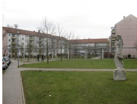
Sanierung Wohngebäude und Wohnumfeldgestaltung Leharhof, Leharstraße (Südhausbau KG)
