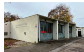
Feuerwehrhaus Ringsee Dahlenstraße 6
