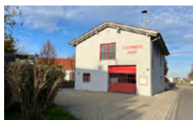
Feuerwehrhaus Pettenhofen Moosweg 9
