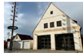
Feuerwehrhaus Zuchering Am Kühlhaus 4
