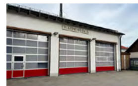
Feuerwehrhaus Unsernherrn Karl-Theodor-Straße 7
