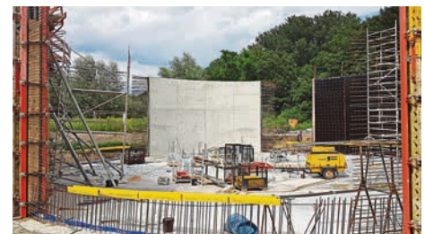
Bau des Stahlbetonbehälters mit 22 Meter Durchmesser
