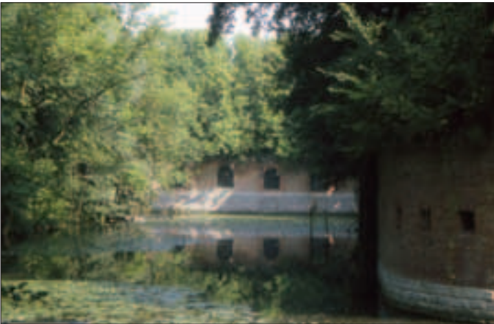
DIE FESTUNGSWERKE SIND OFTMALS KAUM NOCH SICHTBAR AUFGRUND DICHTEN UND HOHEN BEWUCHSES.
