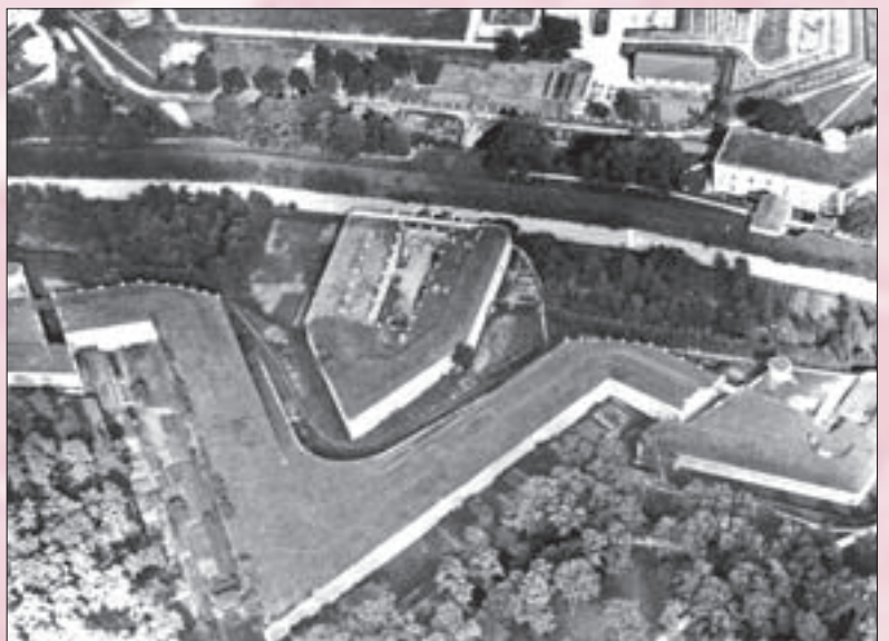
DAS BILD ZEIGT DIE FRONTE PAPPENHEIM: GENAU HIER BEFINDET SICH DER HEUTIGE MTV-PLATZ. IM BILDZENTRUM IST DIE KAPONNIERE DER FRONTE PAPPENHEIM ZU ERKENNEN, DAVOR GELAGERT IST EIN PFEILFÖRMIGES BAUWERK, DIE KONTERGARDE. AM LINKEN UND RECHTEN BILDRAND SIND DIE SOG. REDUITS ZU ERKENNEN. AM RECHTEN HINTEREN BILDRAND IST DAS KAVALIER ZWEIBRÜCKEN ZU SEHEN, IN DEM HEUTE DIE JUGENDHERBERGE UNTERGEBRACHT IST. AM LINKEN BILDRAND ERKENNT MAN ANSATZWEISE DAS KAVALIER HEPP, DAS HEUTE U.A. DAS STADTMUSEUM BEHERBERGT. IM BILDHINTERGRUND KANN MAN KLAR DEN HAUPTWALL ERKENNEN.
