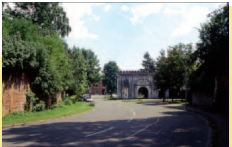
AKTUELLE AUFNAHME VOM TOR HEPP AN DER VON-DER-TANN-STRASSE
