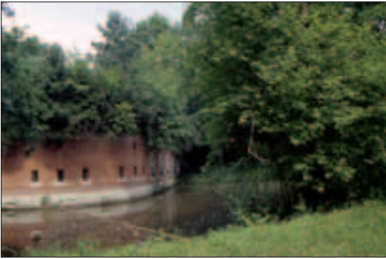
AM KÜNETTEGRABEN, IM BEREICH DER UNREGELMÄSSIGEN FRONTEN
