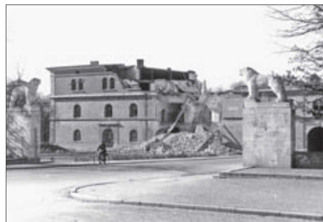
ABBRUCH DES KAVALIER SPRETI AN DER HEUTIGEN HARDERSTRASSE
