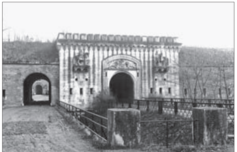
TOR HEPP VOR 1900 IM ORIGINALZUSTAND. DIE HEUTE SICHTBAREN WEITEREN DURCHGÄNGE IM TOR WURDEN FÜR FUSSGÄNGER NACH 1900 GESCHAFFEN, ALS ES ZU ERSTEN KONFLIKTEN MIT DEM DAMALS AUFKOMMENDEN AUTOMOBILVERKEHR KAM.
