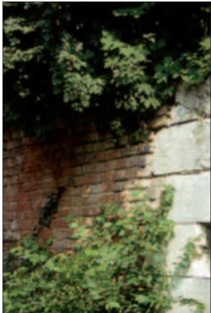
STARKER BEWUCHS AUF UND IM MAUERWERK GEFÄHRDET DIE ERHALTENEN HISTORISCHEN GEBÄUDE UND MAUERN.
