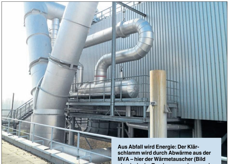
Aus Abfall wird Energie: Der Klärschlamm wird durch Abwärme aus der MVA – hier der Wärmetauscher (Bild oben) – in der Trocknungsanlage zu einem Granulat mit hohem Brennwert
